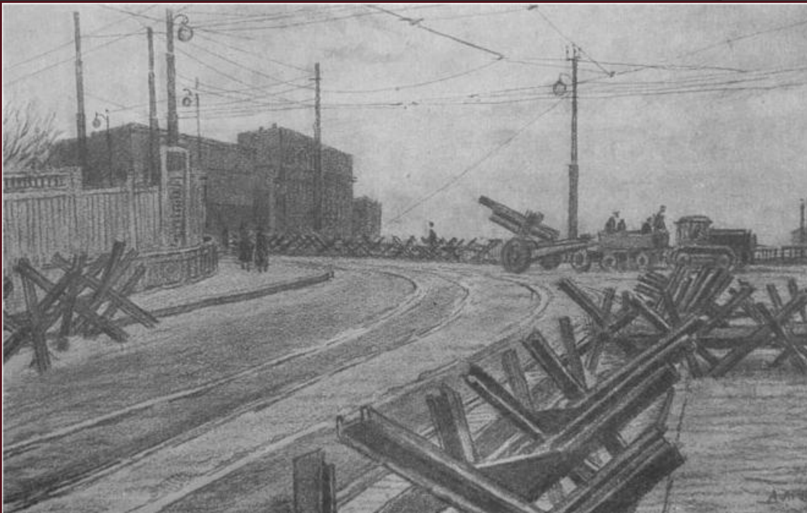
А. М. Лаптев «Оборонительные сооружения у московской заставы» / 1941 г./
